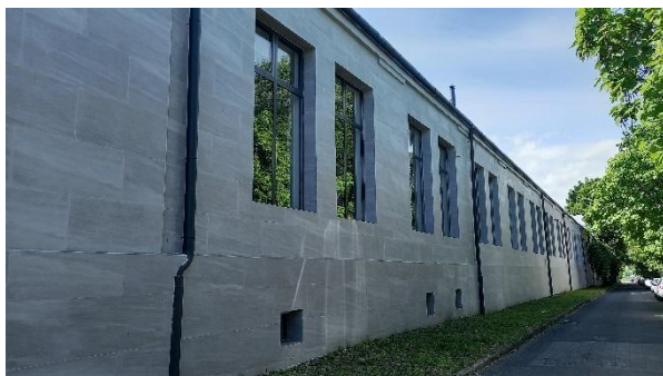
Csarnoképület burkolt oldala a Lámpagyár utcában
