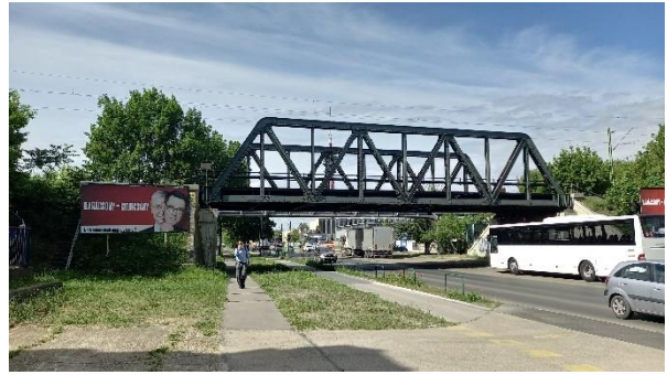
Kőér utcai vasúti híd
