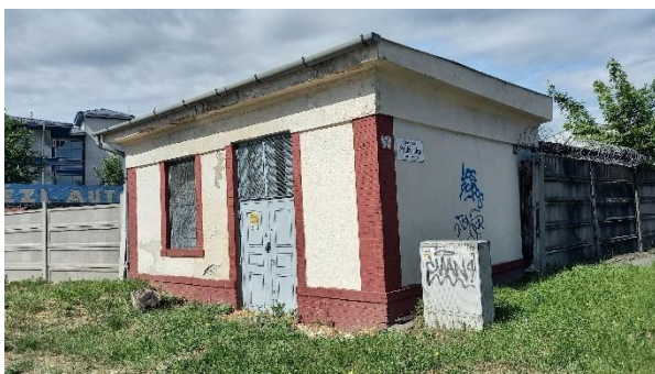
Kőér utca 3/d. szám melletti trafóház
