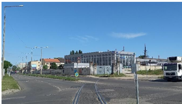
Felújított csarnoképület, Vaspálya utca 23-25.
