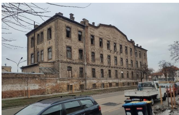
Kőér utca menti pinceszinttel, alagsorral rendelkező épület
