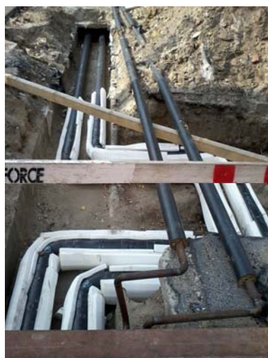
Magasvezetésű távhővezeték a Halom u. 7. sz. előtt
