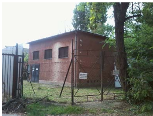
Épületben elhelyezett gáznyomásszabályzó a Liget utcában
