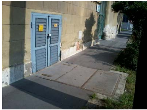
0199 sz. épületben elhelyezett 10/0,4 kV-os transzformátor
