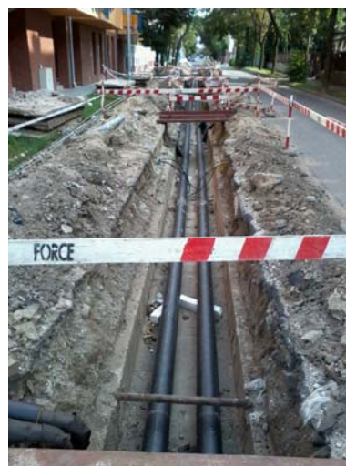
Magasvezetésű távhővezeték a Halom u. 7. sz. előtt
