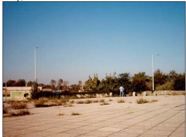
22. Az Üllői úti felüljáró melletti részsű tetején kialakított (elhanyagolt, lepusztult) pihenőterasz
