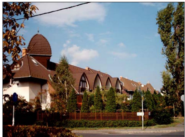
38. A Kőér utcai lakópark épületei
