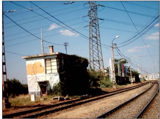
2. Hév-vonal és a rossz állagú vasúti épület (Soroksári és Határ úti csomópontnál)
