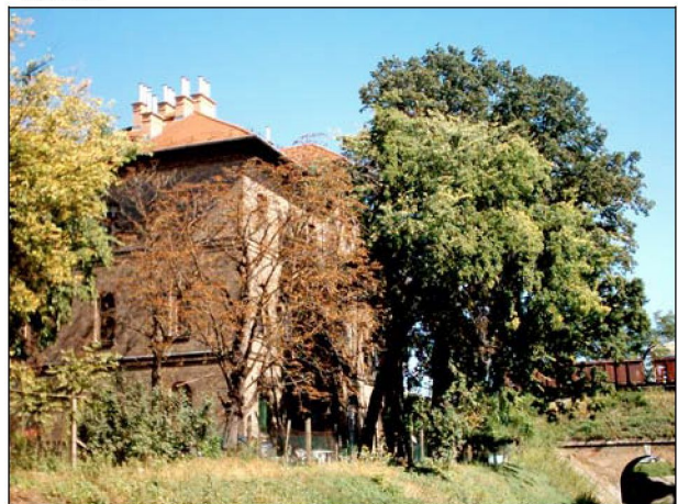
67. A patak partján álló MÁV lakóház
