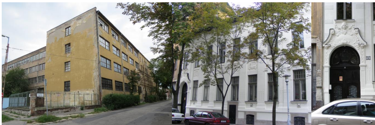
Leromlott állapotú épület- Füzér utca 39
