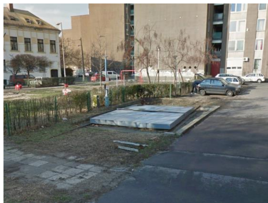
Földbe süllyesztett hálózati gáznyomáscsábályzó a Román utcában
