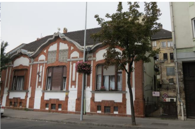
Jó állapotú épület- Állomás utca 1
