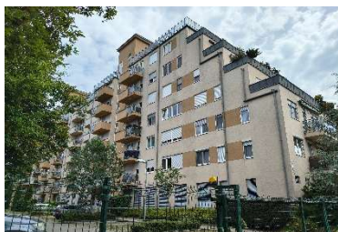
Gém u. 6. Pöttyös Terasz lakópark
