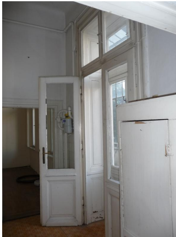
76. a/3 jelű bejárati ajtó belső nézete
