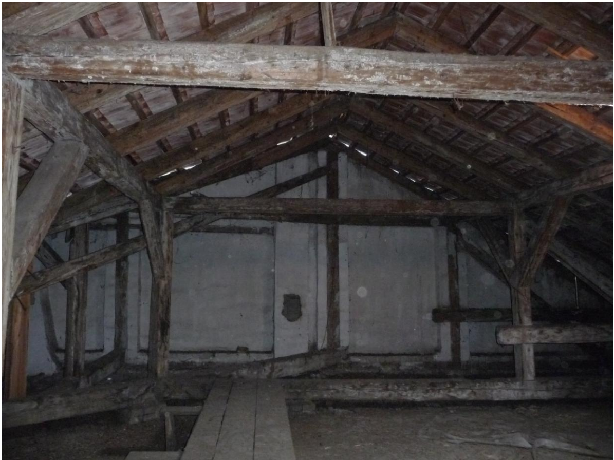
10. Eredeti (1873-1878 közötti) fedélszerkezet az utcai oldalon
