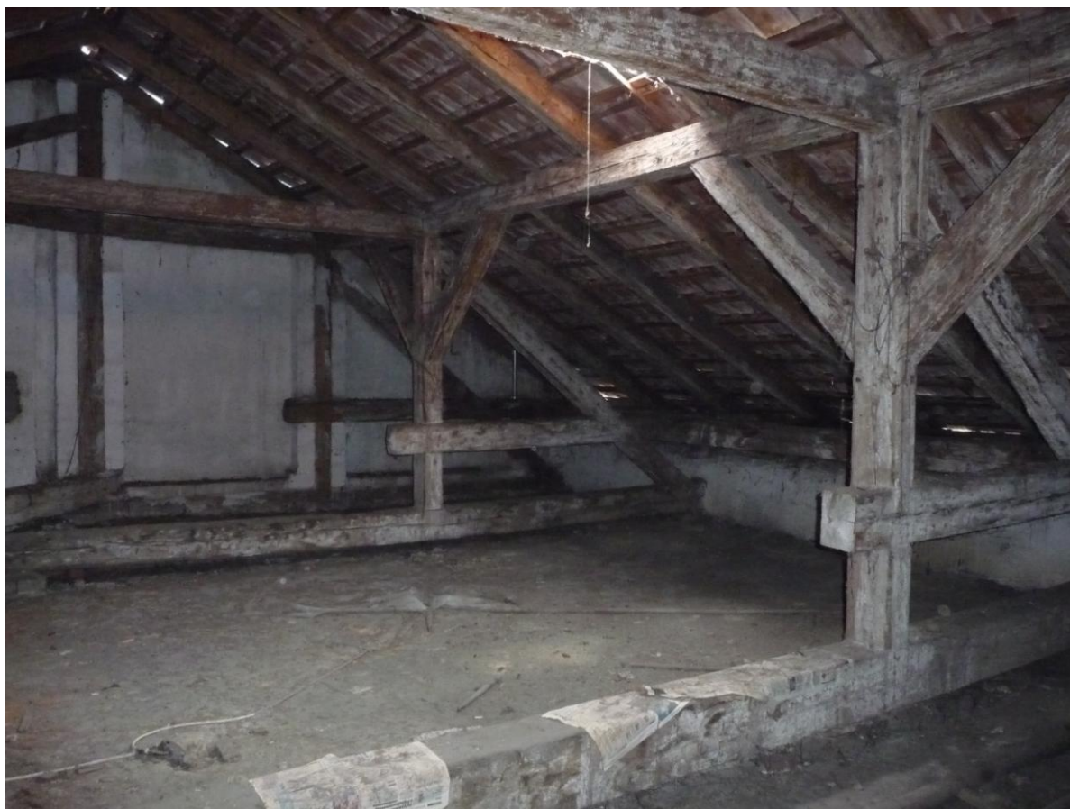
9. Eredeti (1873-1878 közötti) fedélszerkezet az utcai oldalon
