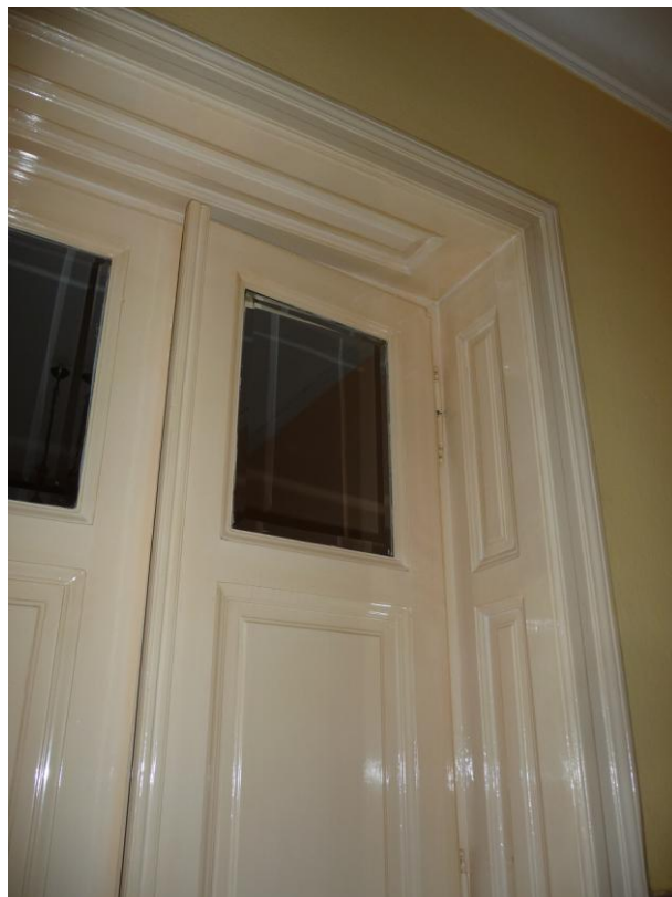
58. b1 jelű ajtó tokborítása és metszett üvegezése
