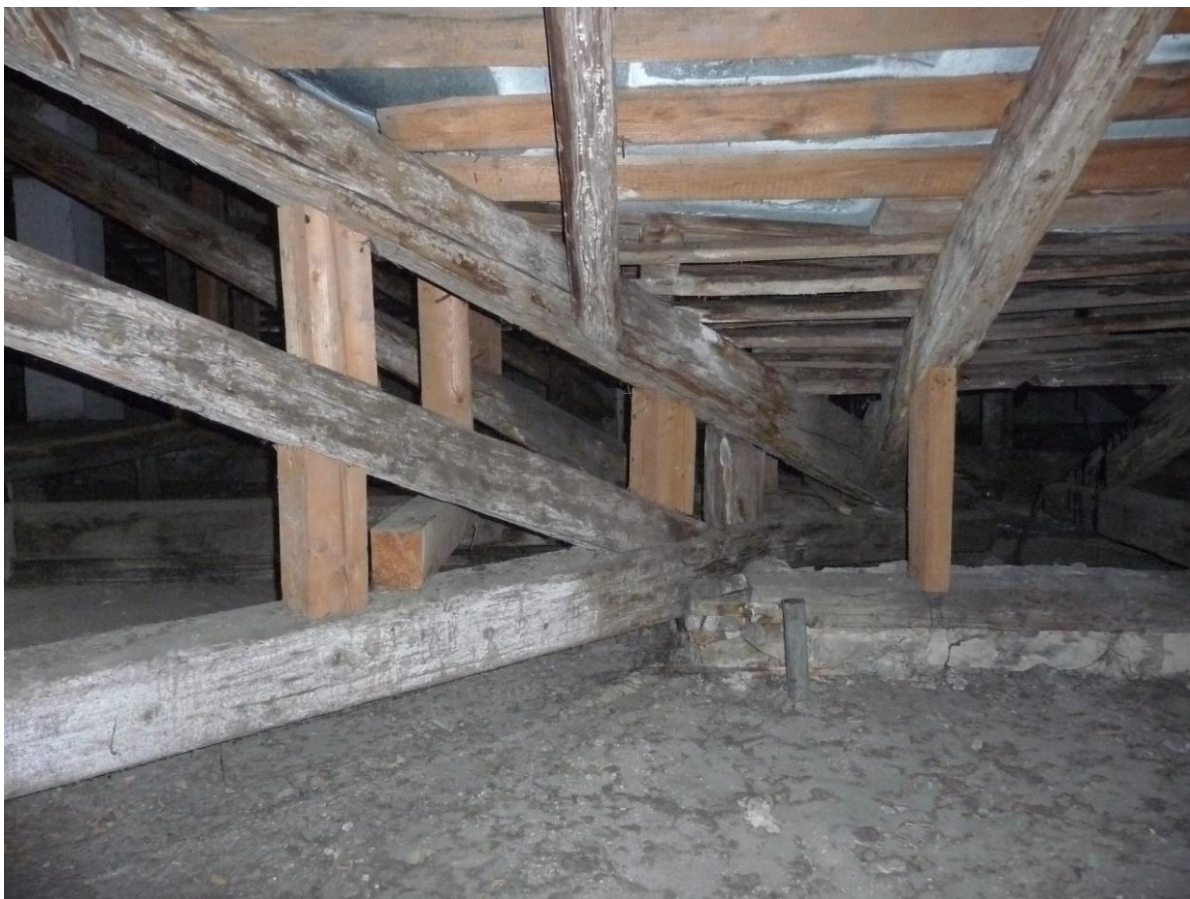
12. A vápacsatorna alatti megerősítés
