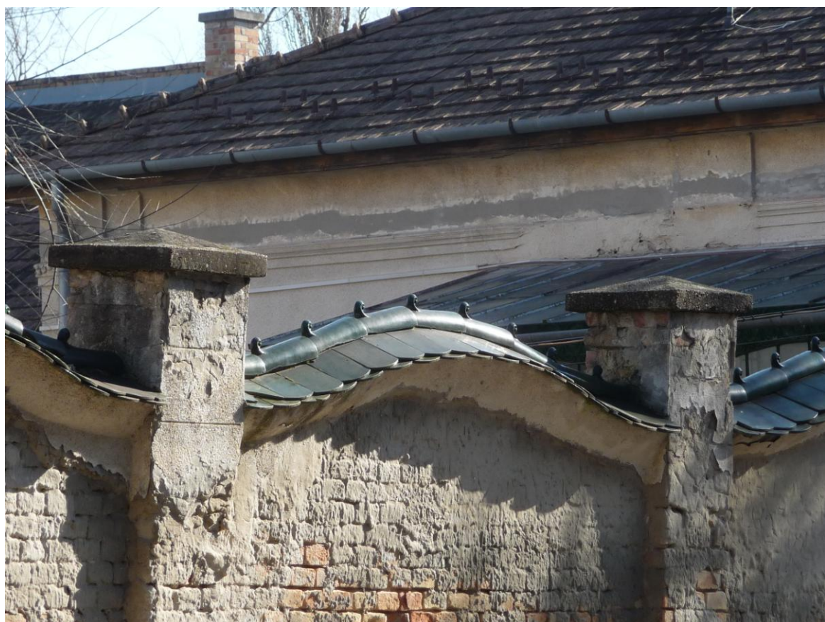
98. A kerítésmezők hullámzó lezárása, fedés Zsolnay cseréppel
