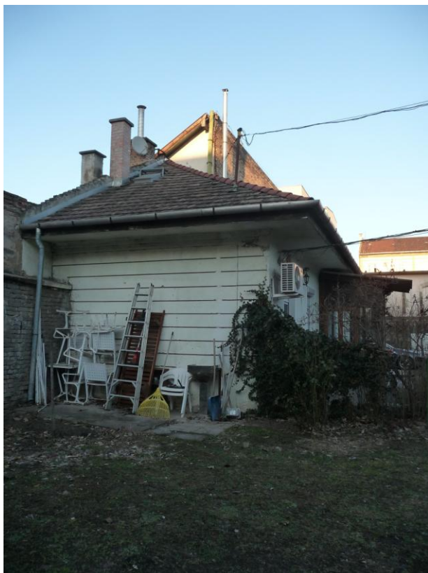
94. A melléképület bütühomlokzata a sarkon lizénával, sávozott vakolattal
