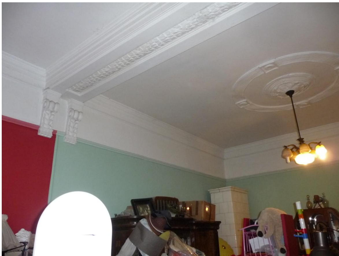
61. Kettős konzolokkal aláfogott, gipsz stukkóval díszített áthidaló a 2/4 helyiségben
