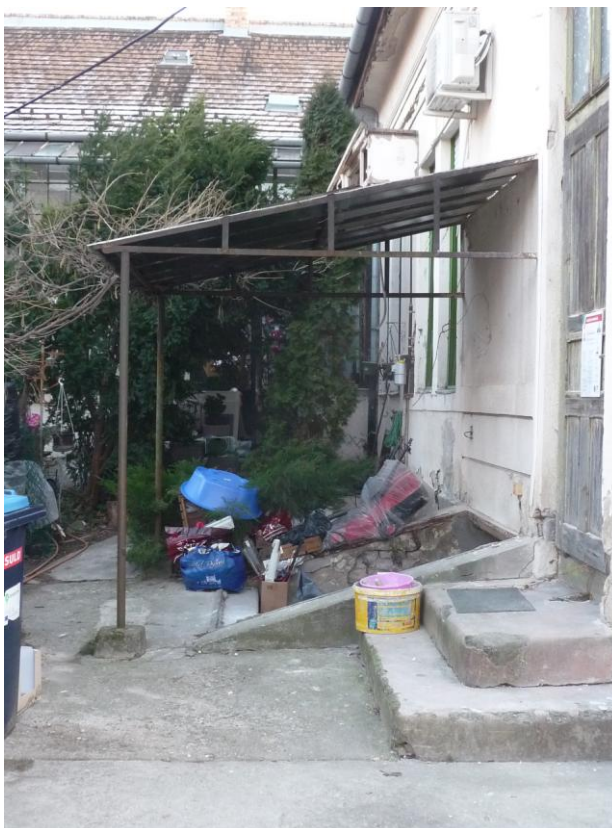
39. Pincelejáró feletti előtető
