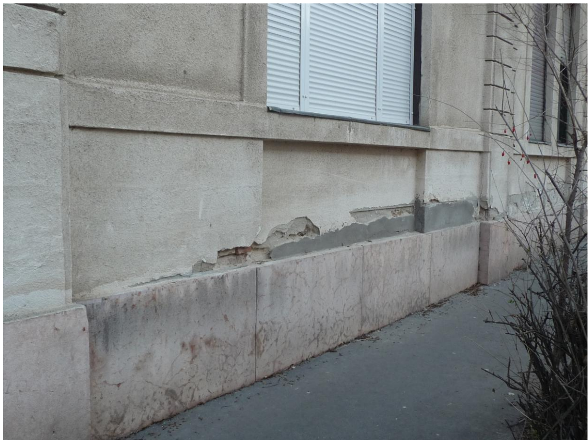
21. Mélyített tükör az ablak alatti egykori köténydíz számára
