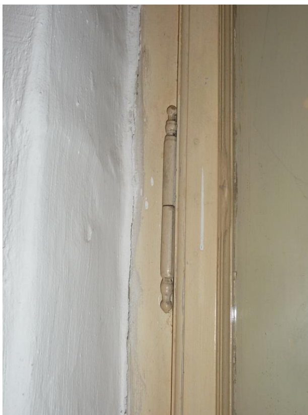
83. Hosszított diópánt az A7 jelű ablakon
