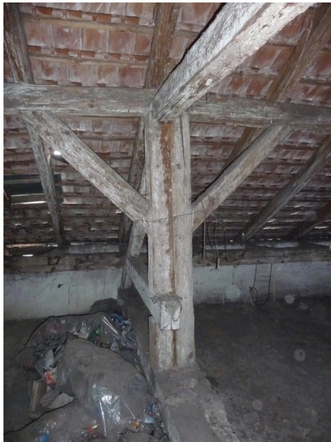
11. Fedélszerkezet bővítése 1903-ban, megkettőzött főállással
