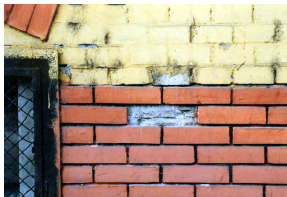
A fal és a lábazat minőségi és méretbeli különbsége
