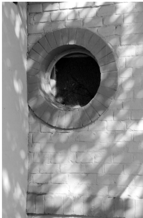
Egy körablak 1941-ből az udvari homlokzaton, eléfalazással és szögletes ablaktokkal
