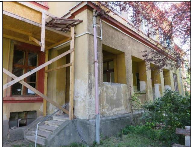
Udvari homlokzat részlet
