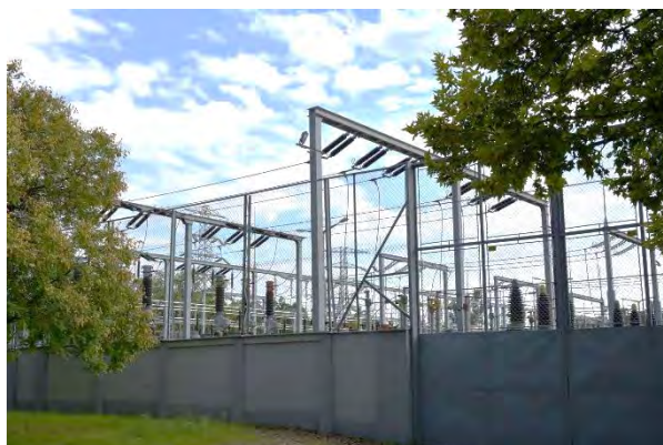
A Népligetben található elektromos alállomás
