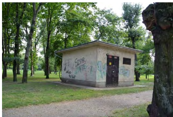
Építetház 10/0,4 kV transzformátor
