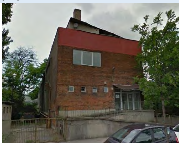
Kőbányai egészségház (forrás: Google Maps)
