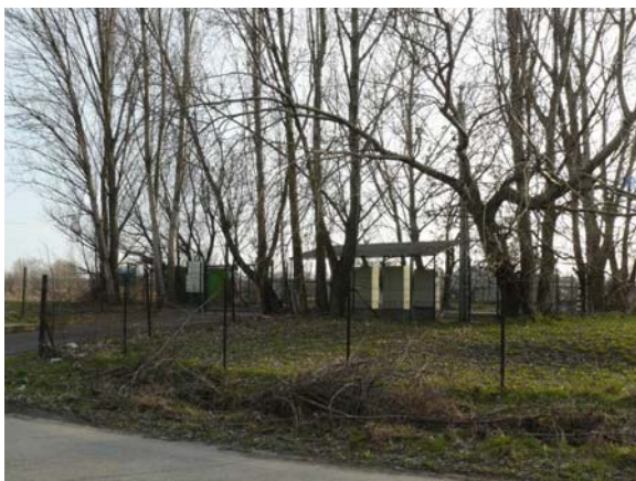
Pilisi utcai automata szennyvízáttemelő
