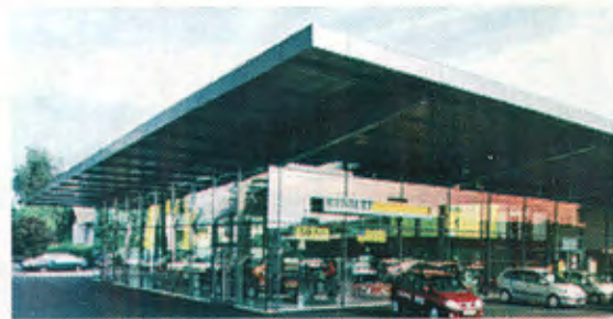
Element-Dach auf Binder
