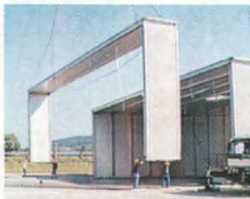
Montage einer Element-Halle
