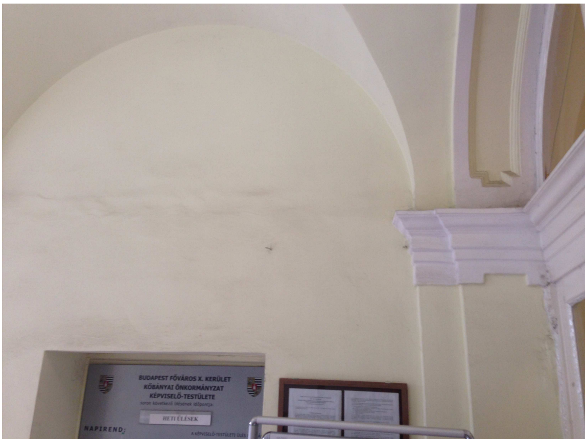
Bal oldali bontandó íves faltest. A falkötést felül az ívnél ellenőrizni kell.
