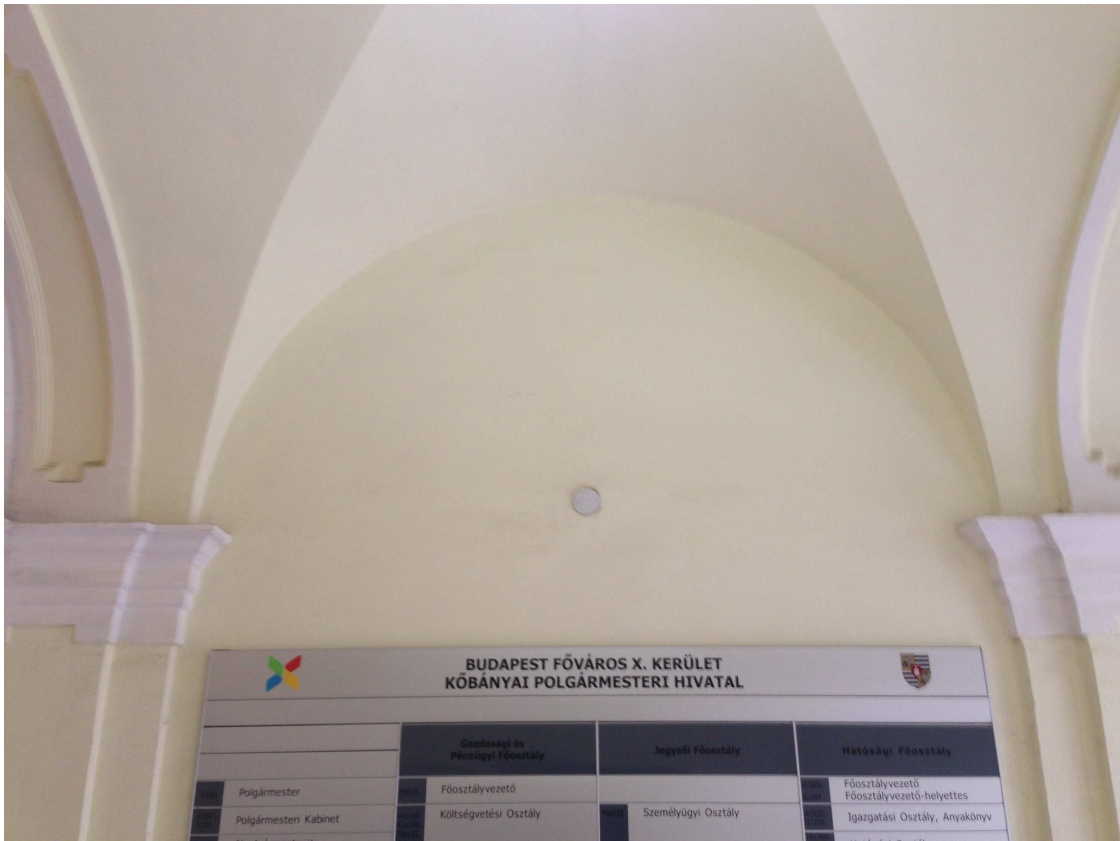
Jobb oldali bontandó íves faltest. A falkötést felül az ívnél ellenőrizni kell.
