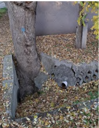
19. ábra: Tetőlefolyók kivezetése szikkasztó árokba és a járdára (forrás: szerzői fotó)
