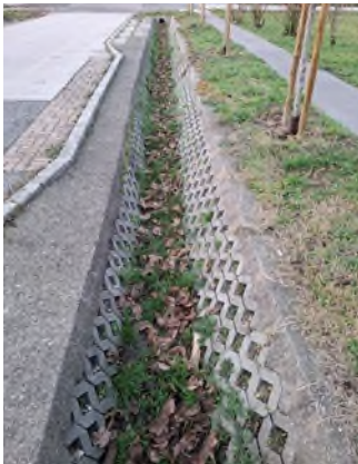
17. ábra: Gyepborítású szikkasztóárok, illetve gyephézagos burkolattal ellátott elvezető árok (forrás: szerzői fotó) 18. ábra: Csapadékvíz-bevezetés a Szilas-patakba (forrás: Főpolgármesteri Hivatal / Képszerkesztőség / Tuba Zoltán)
