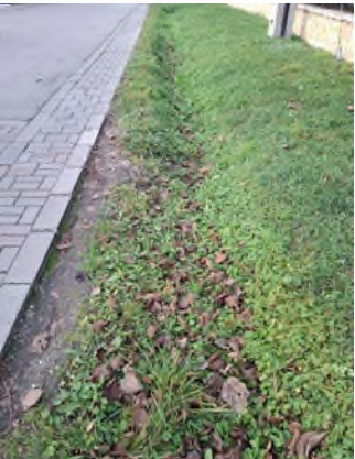
17. ábra: Gyepborítású szikkasztóárok, illetve gyephézagos burkolattal ellátott elvezető árok (forrás: szerzői fotó) 18. ábra: Csapadékvíz-bevezetés a Szilas-patakba (forrás: Főpolgármesteri Hivatal / Képszerkesztőség / Tuba Zoltán)
