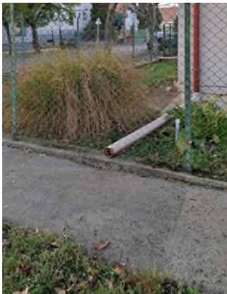
19. ábra: Tetőlefolyók kivezetése szikkasztó árokba és a járdára (forrás: szerzői fotó)
