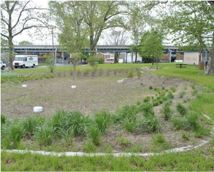
40. ábra: Új telepítésű esőkert túlfolyókkal (forrás: Zöldinfrastruktúra füzetek 8. Szivacs város Csapadékvíz visszatartása városi környezetben)
