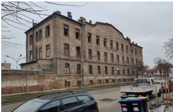
Kőér utca menti pincészinttel, alagsorral rendelkező épület
