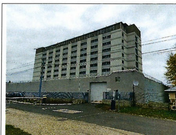
Fővárosi Büntetés-végrehajtási Intézet épülete
