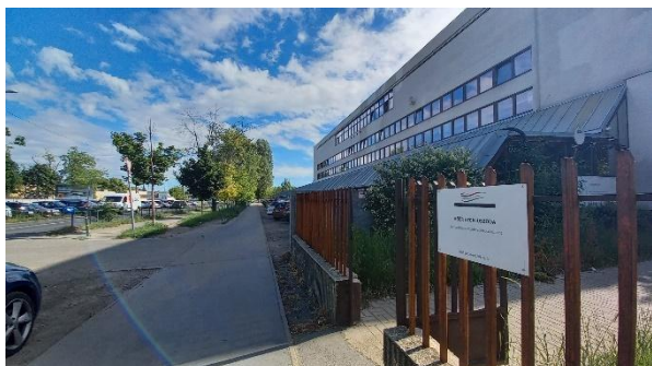
Kőér utcai uszoda
