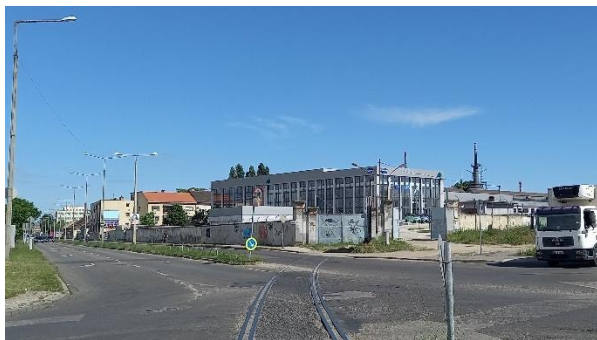
Felújított csarnoképület, Vaspálya utca 23-25.
