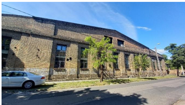
Védett csarnoképület, Cserkesz utca 41-43.
