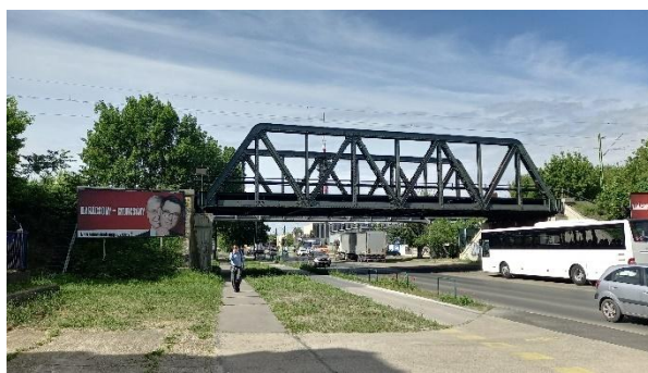
Kőér utcai vasúti híd
