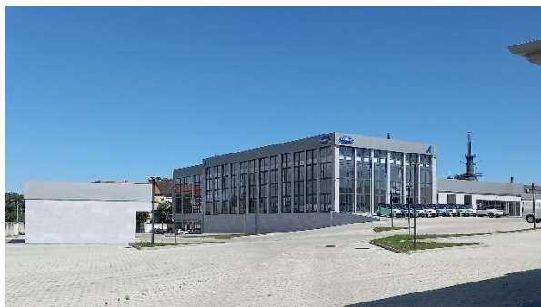
Felújított csarnoképület a Vaspálya utca – Kőér utca – Gyömrői út kereszteződése felől
