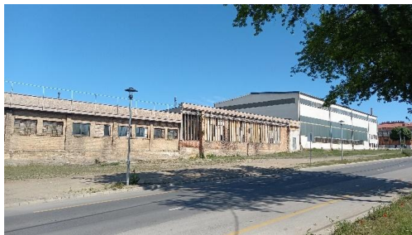
Kőér utca menti csarnoképületek
