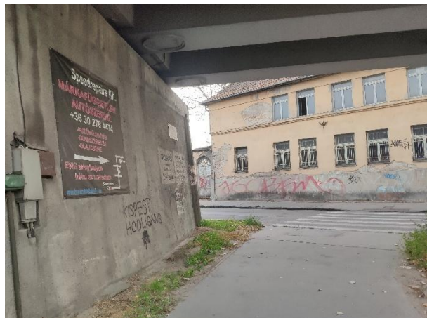
A Ferihegyi repülőtérre vezető gyorsforgalmi út – Gyömrői út csomóponti híd
