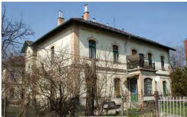
A DK-i rövidhomlokzat az átalakított előépítménnyel
