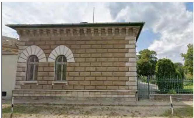
Fogadóépület Kozma utcai homlokzata
