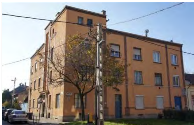
A Szállás utca felőli homlokzat
