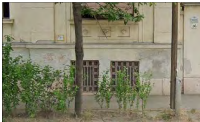
Homlokzati díszítés az ablak alatt, alagsori ablakrács
