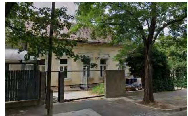
Az épület Dömsöd utcai oldala
