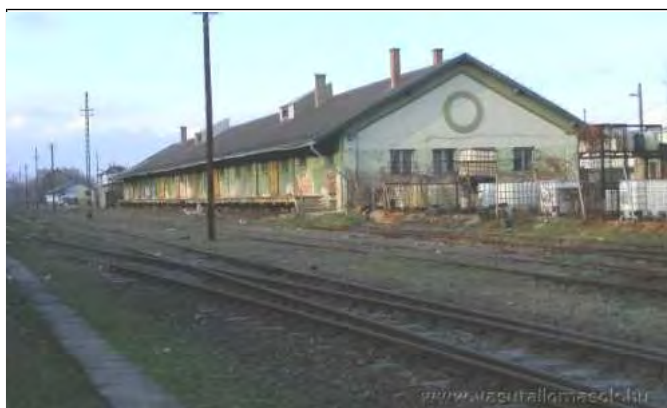
A raktárépület a vasút irányából
