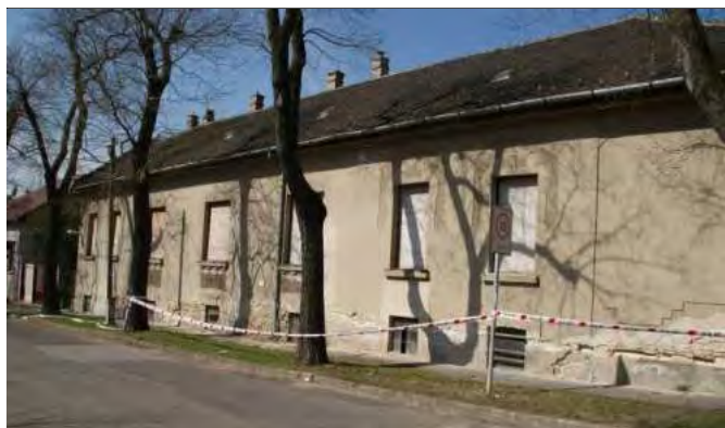
Márga utca felőli homlokzat (2014)
