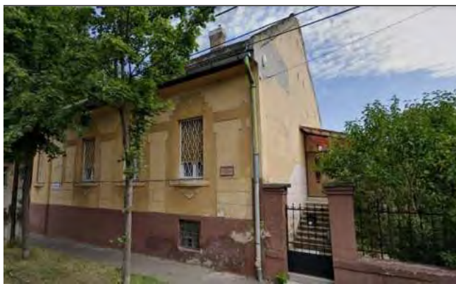
Petrőczy utca felőli homlokzat
