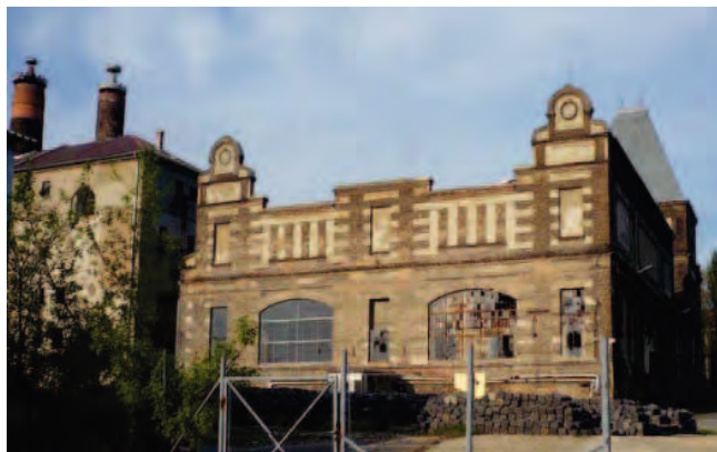
A korabeli erőtelep épülete
