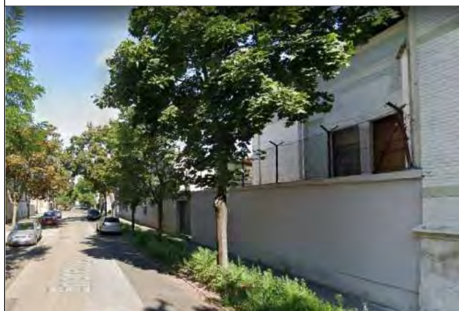
Endre utcai kerítés – bontásra javasolt
