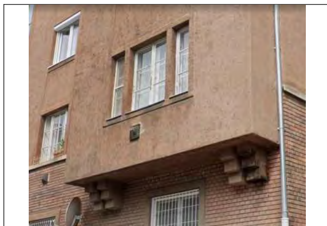
Támpilléres zárterkély eredeti nyílászárókkal
