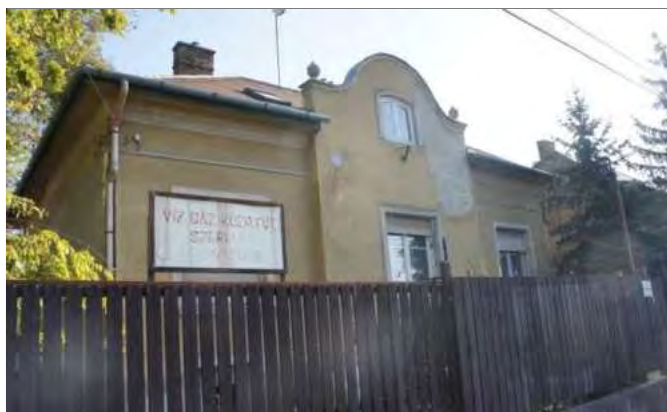
Az épület kiemelt középső traktusa (2014)
