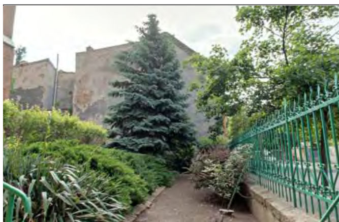
Az épület tűzfala a templomkert felől
