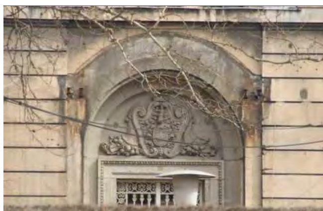
Címerdísz a műkö kapukeret lunettájában, a bejárat fölötti lámpás vas-üveg előtető hiányzik, pótlendő
