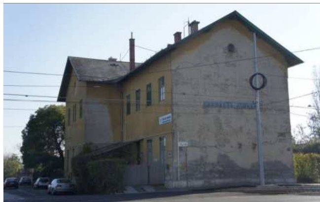
Az állomásépület Bihari utca felőli homlokzata (2019)
