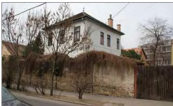
Udvar felőli homlokzat
