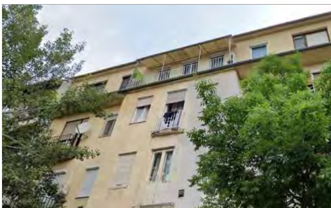
Gergely utca 54. utólagos emeltráépítése
