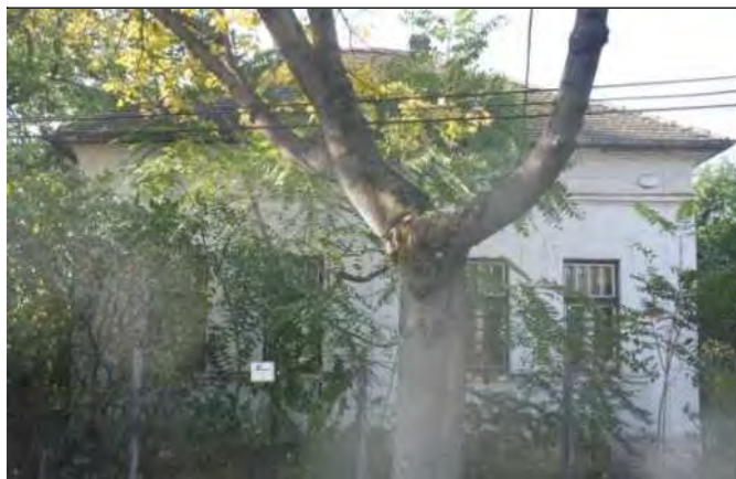
Az épület utcahomlokzata 1.
