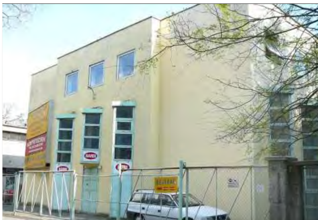
Az egykori moziépület főhomlokzata 2011-ben: erősen átalakított látvány, kerítéssel leválasztott tömeg, megváltozott hasznosítás
