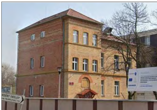
Az épület nyugati és északi homlokzata
