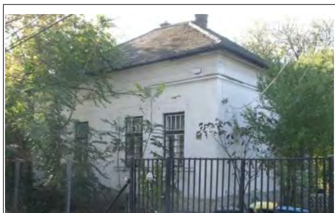
Az épület utcahomlokzata 2.
