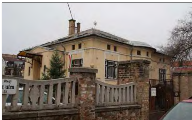
Udvar felőli homlokzat
