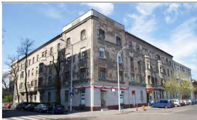
Felújítás előtti utcai homlokzat
