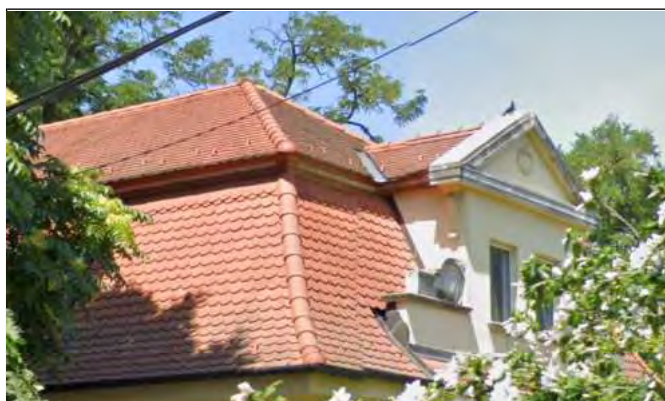
A kiemelt ablakfelépítmény
