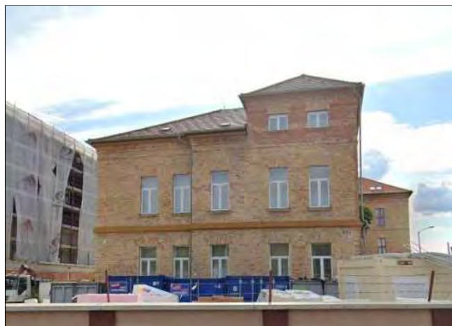
Az épület Pongrác utca felőli homlokzata felújítás közben
