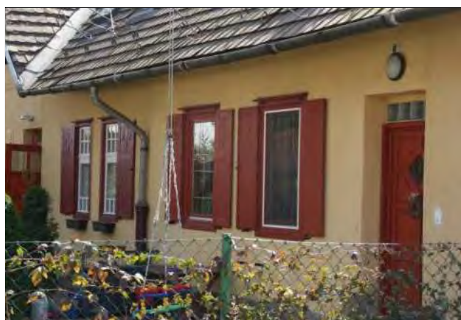
Részletek – felújított spalettás ablakok
