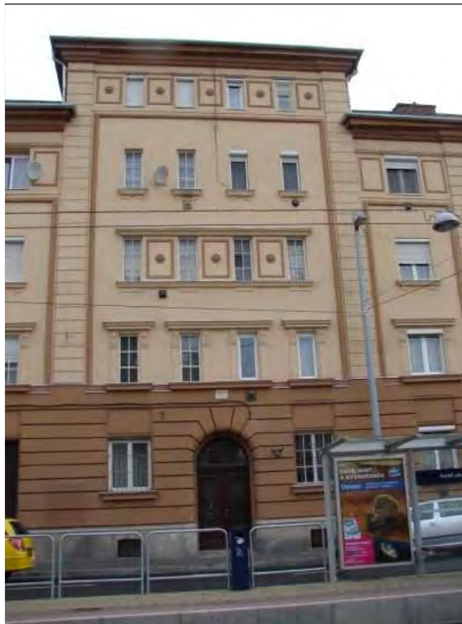
Az épület Bihari utcai homlokzatának középső traktusa
