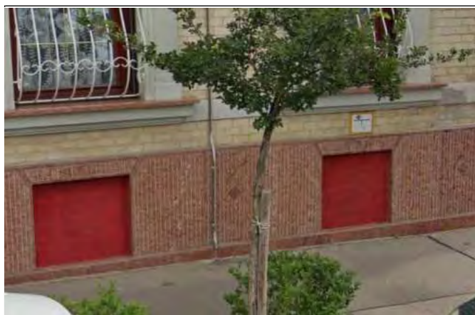
A felújított kőlabazat (2019)
