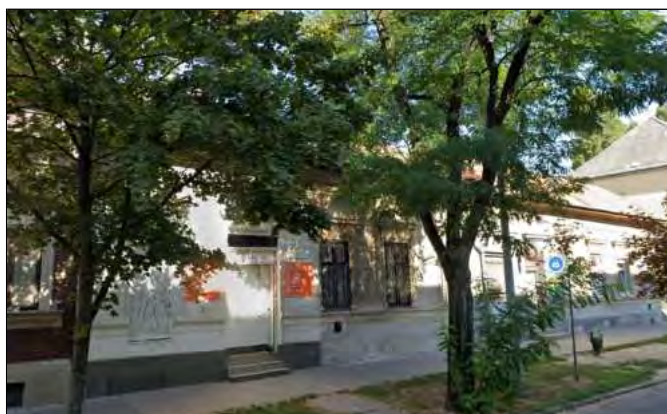
Ónodi utca felőli homlokzat
