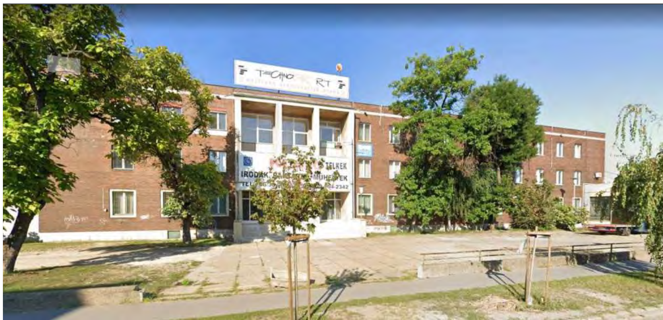
Fertő utcai homlokzat
