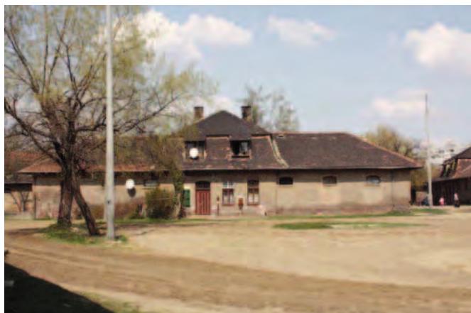
Istállóépület, a középső traktusában lakásokkal
