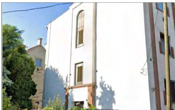
Oldalhomlokzaton lévő lépcsőházi ablak
