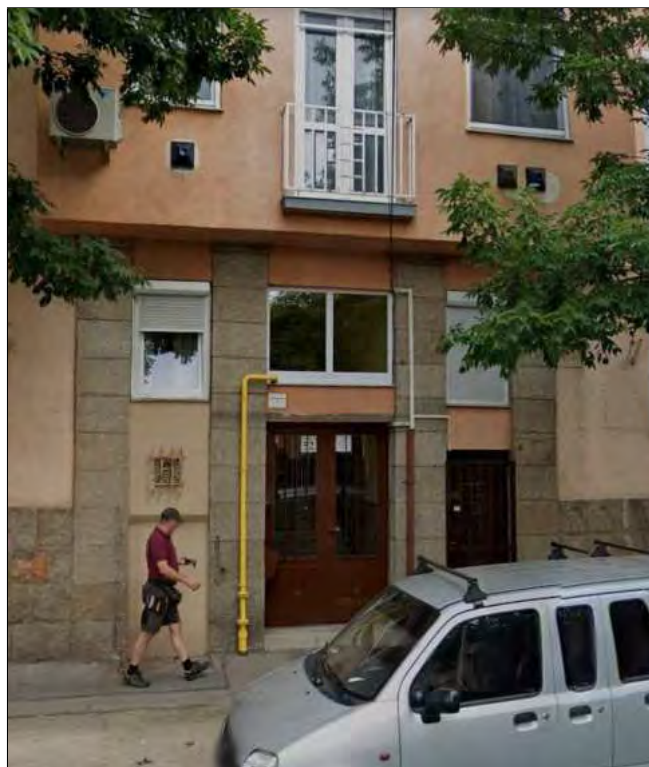
A bejárat környéke műanyag ablakokkal, külső redőnytokokkal, gázcsővel, műanyag kábelcsatornával, konvektor kivezetővel, légkondi külső egységgel
