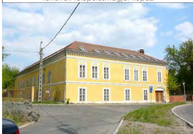
A szomszédos 1887-ben épült iskola épülete, mely fővárosi értékvédelem alatt áll
