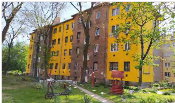
Felújított homlokzat, harsány színezéssel (keleti épület)
