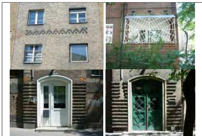
A részletek durva átalakítása, stílusidegen cseréje, homlokzati architektúra szétverése az együttes elértéktelenedéséhez vezethet (ablakcsere, ablakrács, aszimmetrikus kapu, levert tégladísz stb.)
