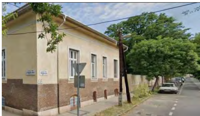
Ihász utca felőli homlokzat
