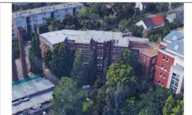
A Déli épületszárny jelenleg az emeletráépítéssel, háttérben a kéményekkel
