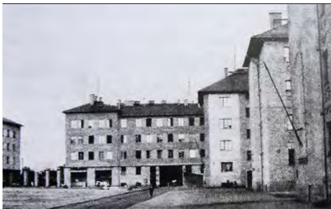
Az I.A-B kapuépületek a pergolával az építés korában (forrás: Ferkai András)
