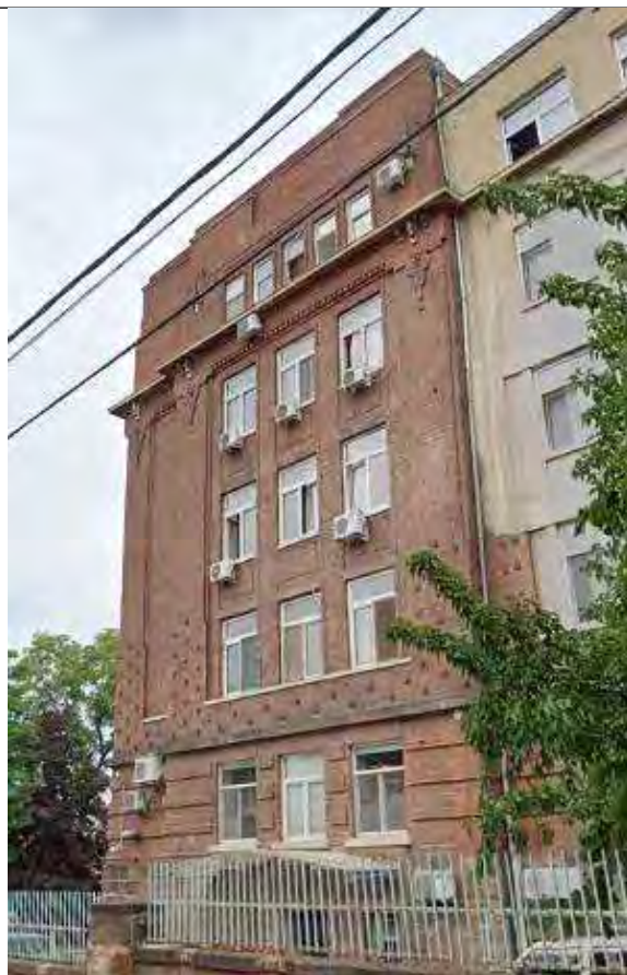
Gazdagon díszített homlokzat a Sörgyár és a Lavotta utca sarkán álló épületen 1.
