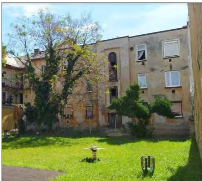
Udvar felőli homlokzat
