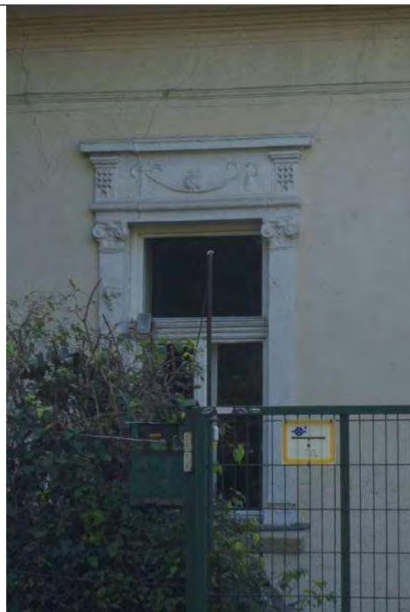
Ablak az utcahomlokzaton
