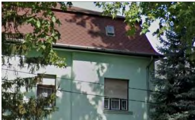
Az utcai homlokzat ablakai
