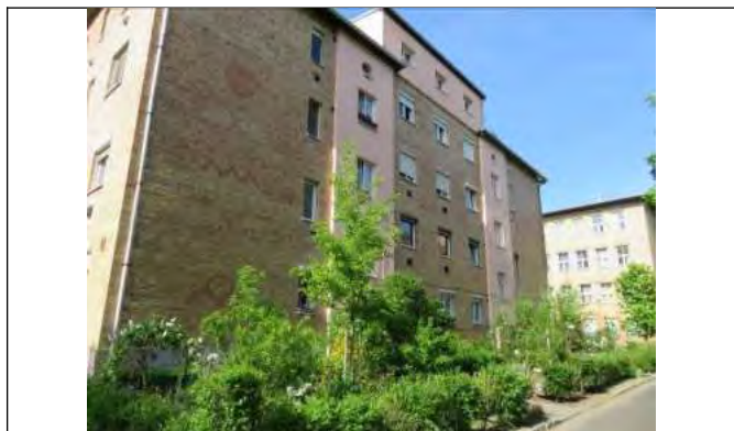
A déli épület felújított homlokzata
