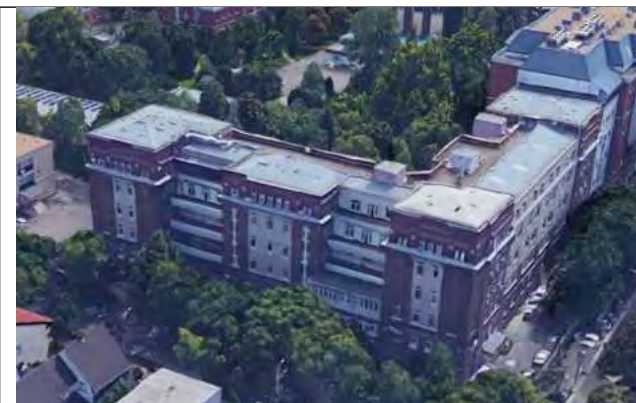
A Lavotta utcai épületszárny jelenleg
