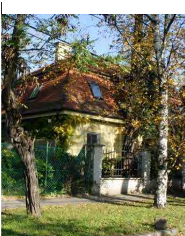
Az épület utcahomlokzata
