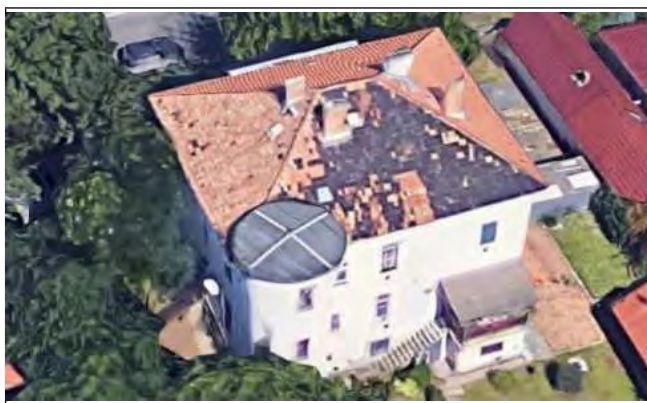
Az udvar felőli homlokzat és a lépcsőház
