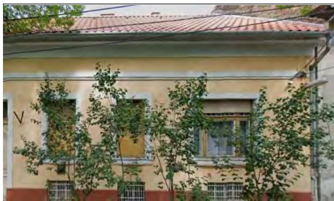
Az lecsupaszított utcai homlokzat ablakai
