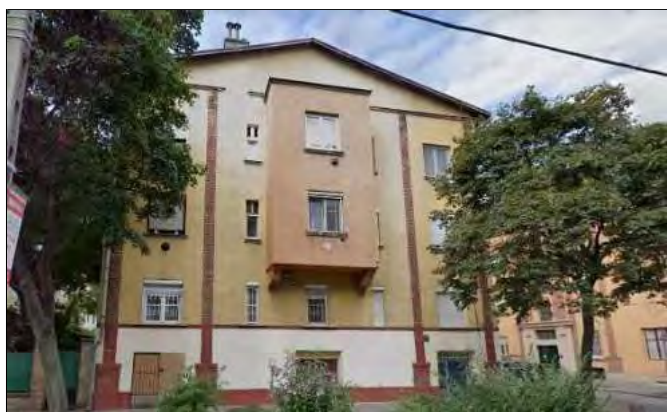
Szállás utca felőli homlokzat
