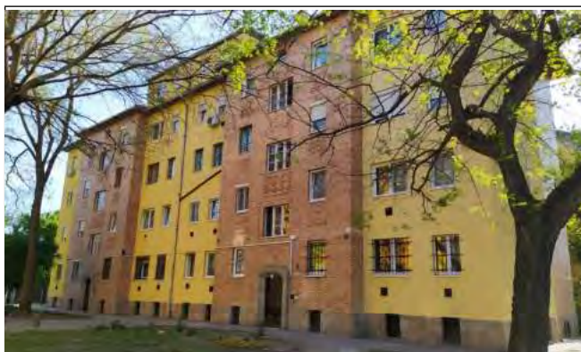
Felújított homlokzat, megtisztított téglaburkolatok
