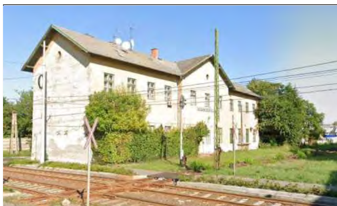
Az állomásépület vasút felőli homlokzata (2019)
