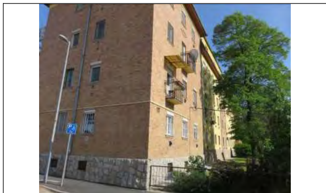
18. szám alatti épület nyugati homlokzata
