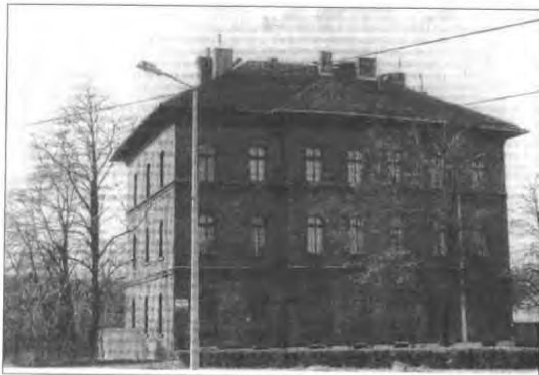
A kétemeletes típus vámház épületek egyike
