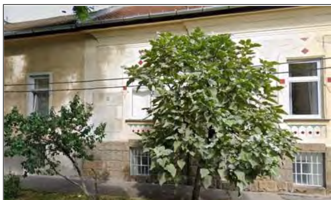
Csatlakozás a Nyitra utca 10. épülethez
