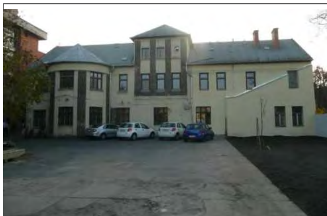
Az épület hátsó homlokzata
