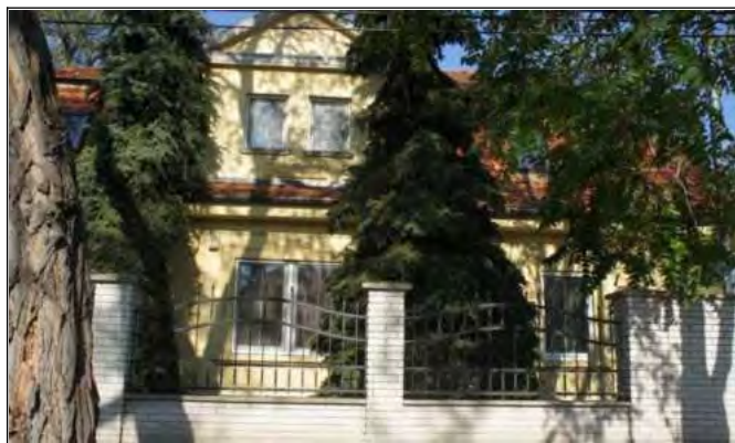
Az épület utcahomlokzata
