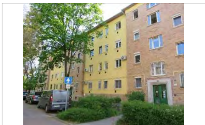
18. szám alatti épület keleti homlokzata
