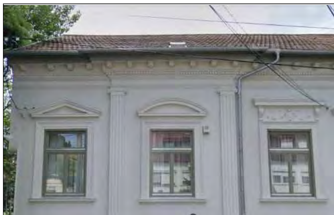
A felújított homlokzat díszes szemöldökpárkányai és ablakkeretezései (2019.)
