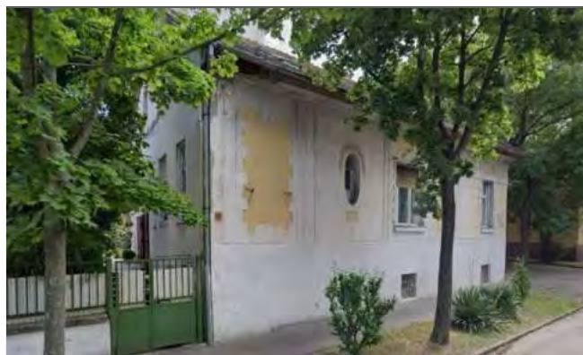
Petrőczy utca felőli homlokzat
