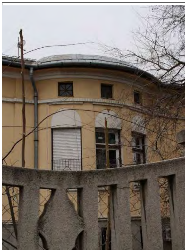
Elliptikus ívű zárterkély
