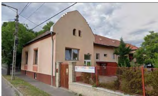
Az Óhegy utca felőli homlokzat
