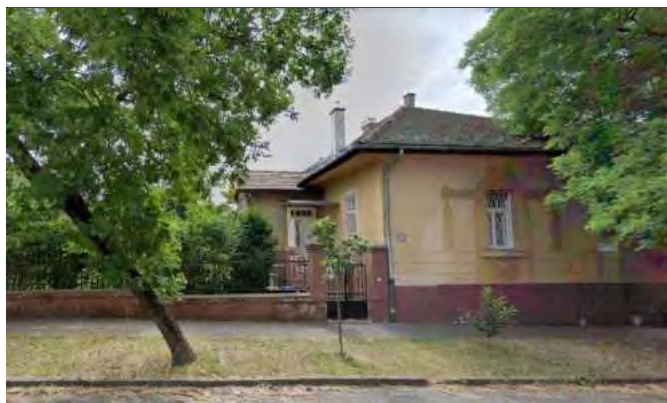
Márga utca felőli homlokzat
