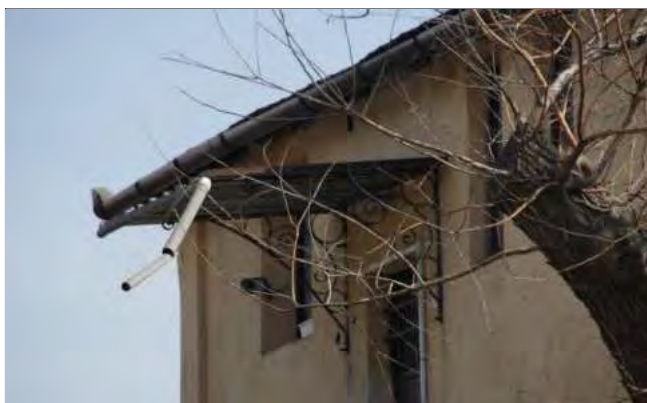
Bejárat feletti tető - részlet
