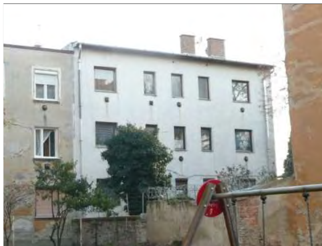
Udvar felőli homlokzat
