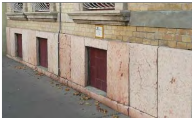
Kőlabazat az utcahomlokzaton (2014)
