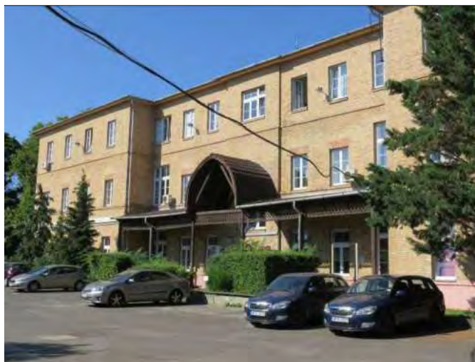
A VI/B. sz. épület keleti homlokzata
