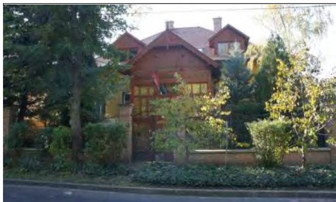
Az épület utcahomlokzata
