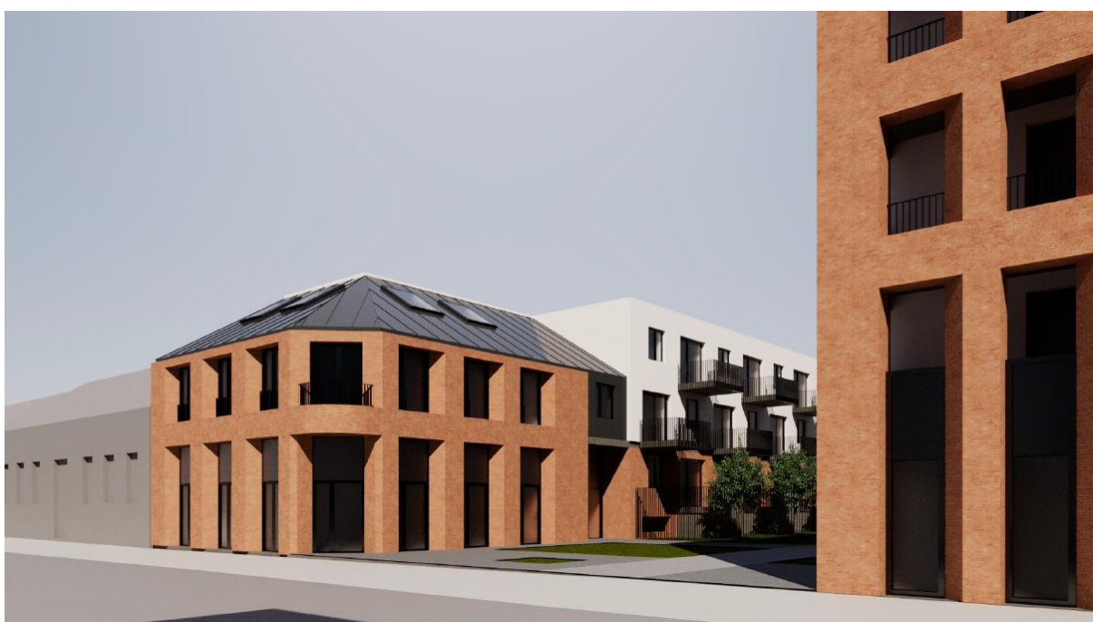
Bánya utcai nézet az alacsonyabb beforduló épülettömegről (forrás: In-Management Szolgáltató Zrt. – ARCHIPLAN Építész Iroda)
