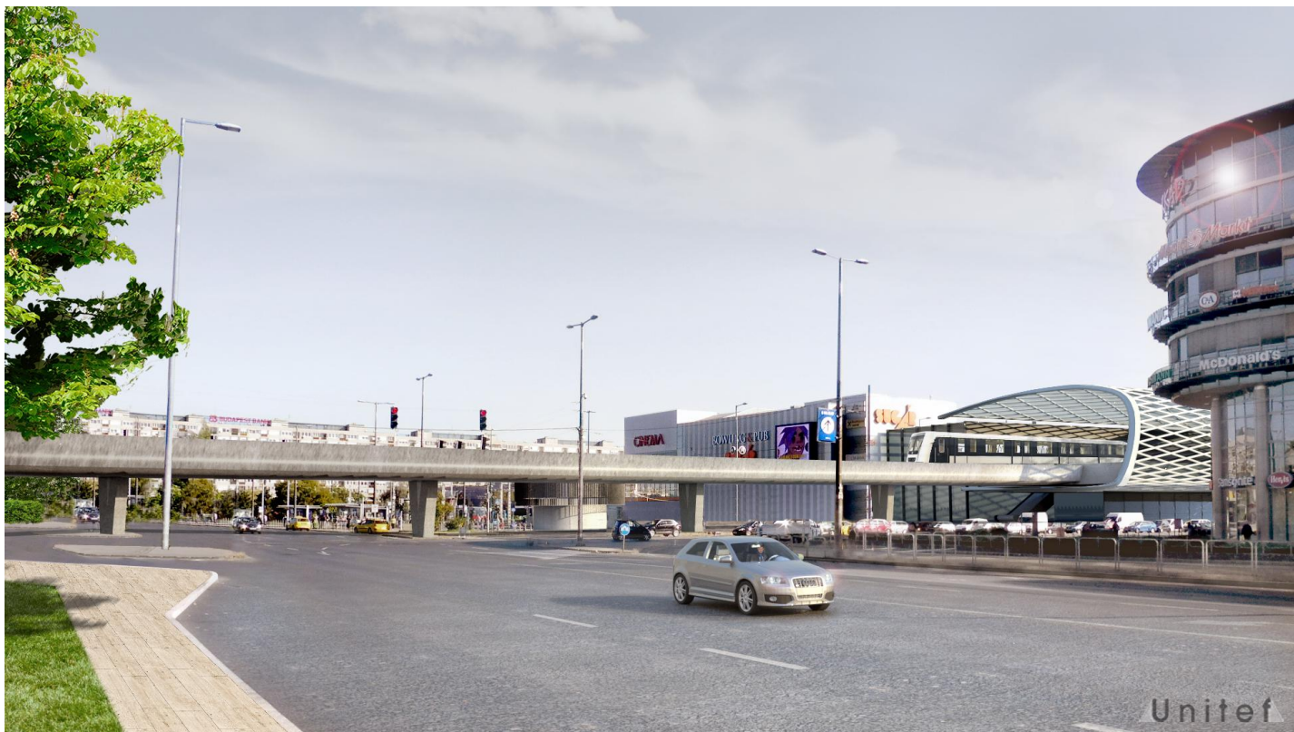
METRÓ MŰTÁRGY ÁTVEZETÉSE AZ ÖRS VEZÉR TERÉN
