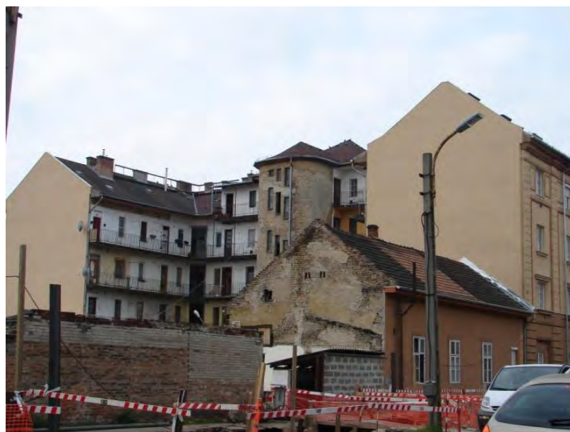
Az épület belső homlokzata, középen a lépcsőházzal
