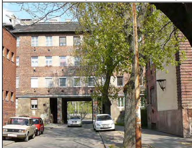
Az I/b. sz. kapuépület téglasávós, az ablakokat vakolt mezőkkel összekötő homlokzata ma; baloldalt az iskola bővítvényeként később épített emeletes tömb
