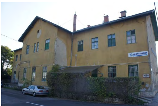
Az állomásépület Horog utca felőli homlokzata
