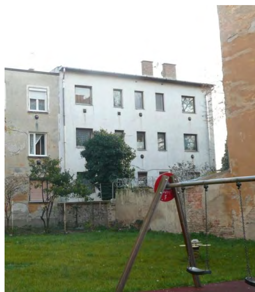
Az épület udvar felőli, hátsó homlokzata
