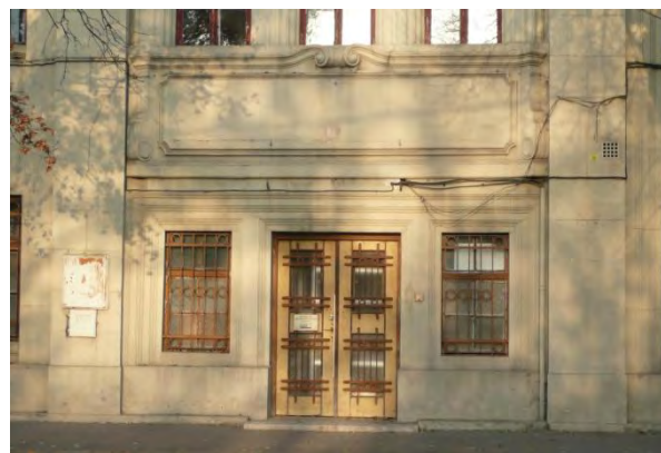
Az épület főbejárata
