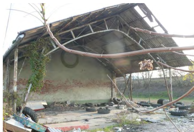
A raktár északi oldalán álló acél-tetőszerkezet
