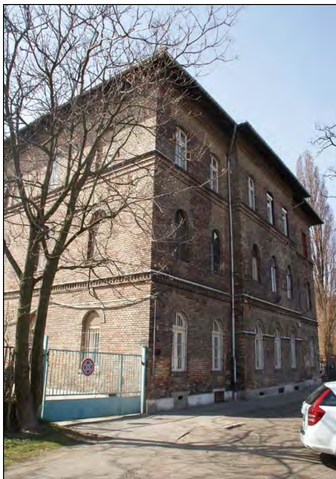
Kőbányai út felőli homlokzat
