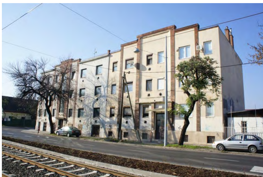
Az épület utcahomlokzata (baloldalán a hozzá nagymértékben hasonlító, ugyancsak háromemeletes lakóépület)
