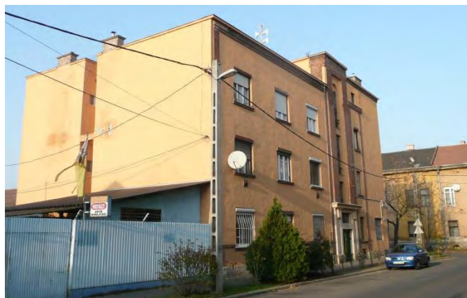
Az épület délkeleti tűzfala
