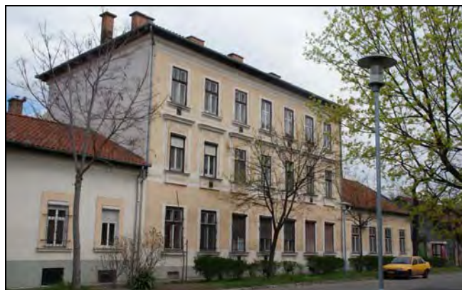
A MF+2 emeletes épületrész
