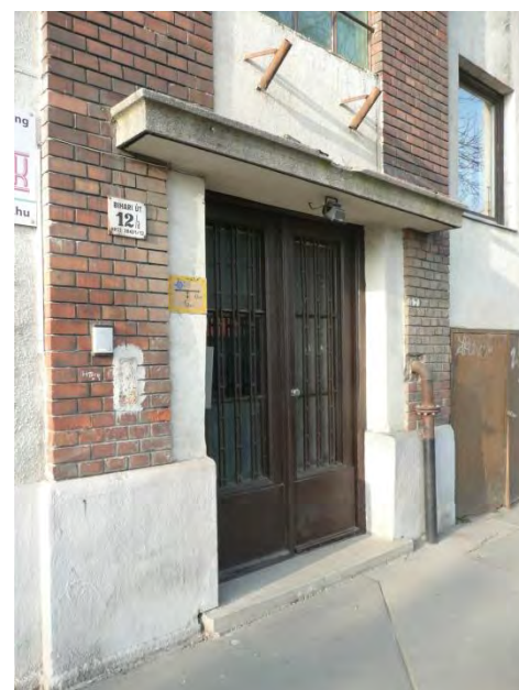
Az épület bejárata
