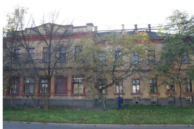
Az épület középső, illetve északi traktusa
