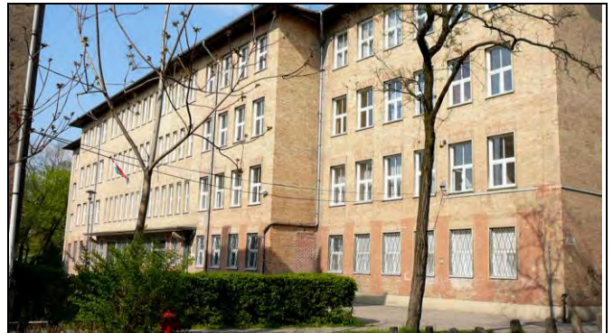
A bejárat fölötti széles rizalit tagolja a téglaburkolatos homlokzatot, melyet erősen kiugró párkány zár le
