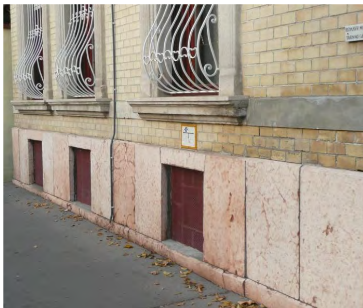
Kőlabazat az utcahomlokzaton
