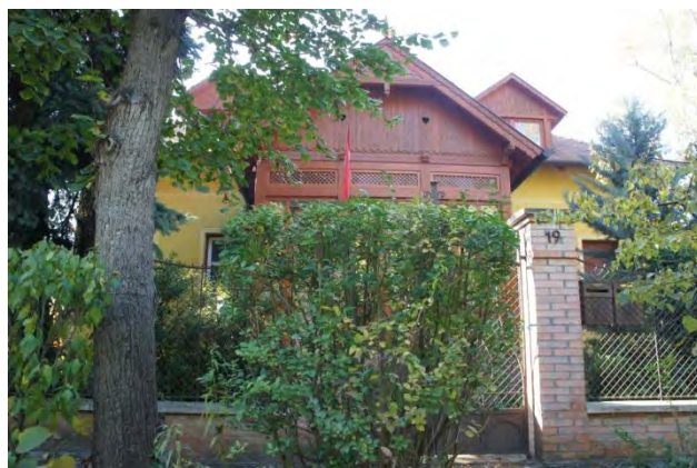
Az veranda faszerkezete
