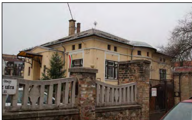
Udvar felőli homlokzat
