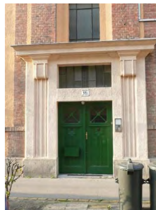
Az épület főbejárata
