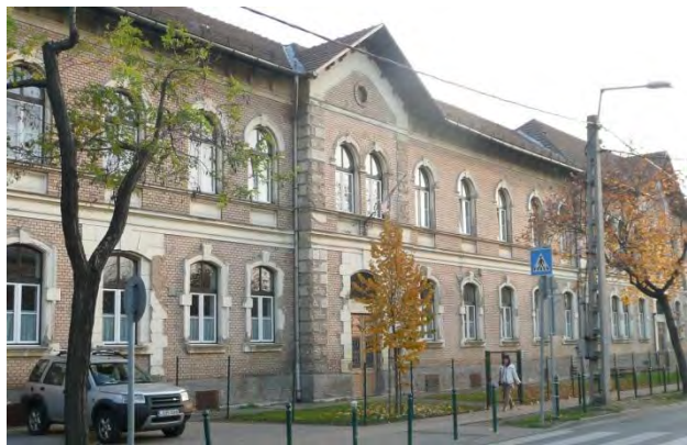
Az iskola utcahomlokzata
