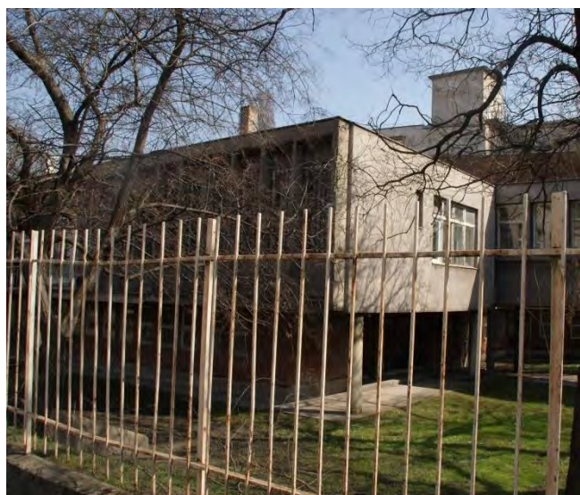
Az épület északi szárnya a Kismartoni út irányából
