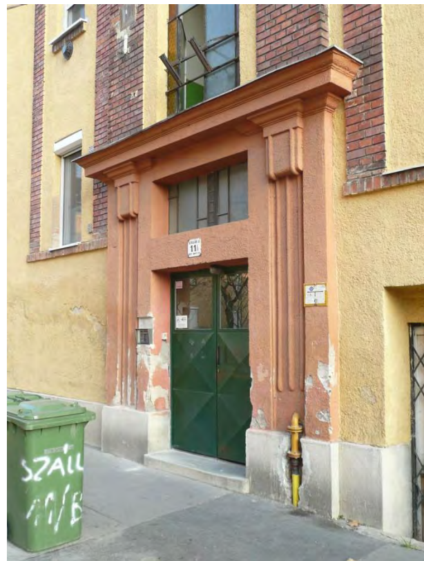
Az épület főbejárata
