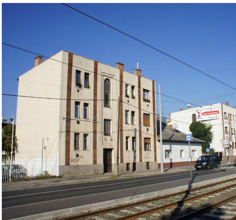
Az épület Bihari utca felőli homlokzata, és délkeleti tűzfala
