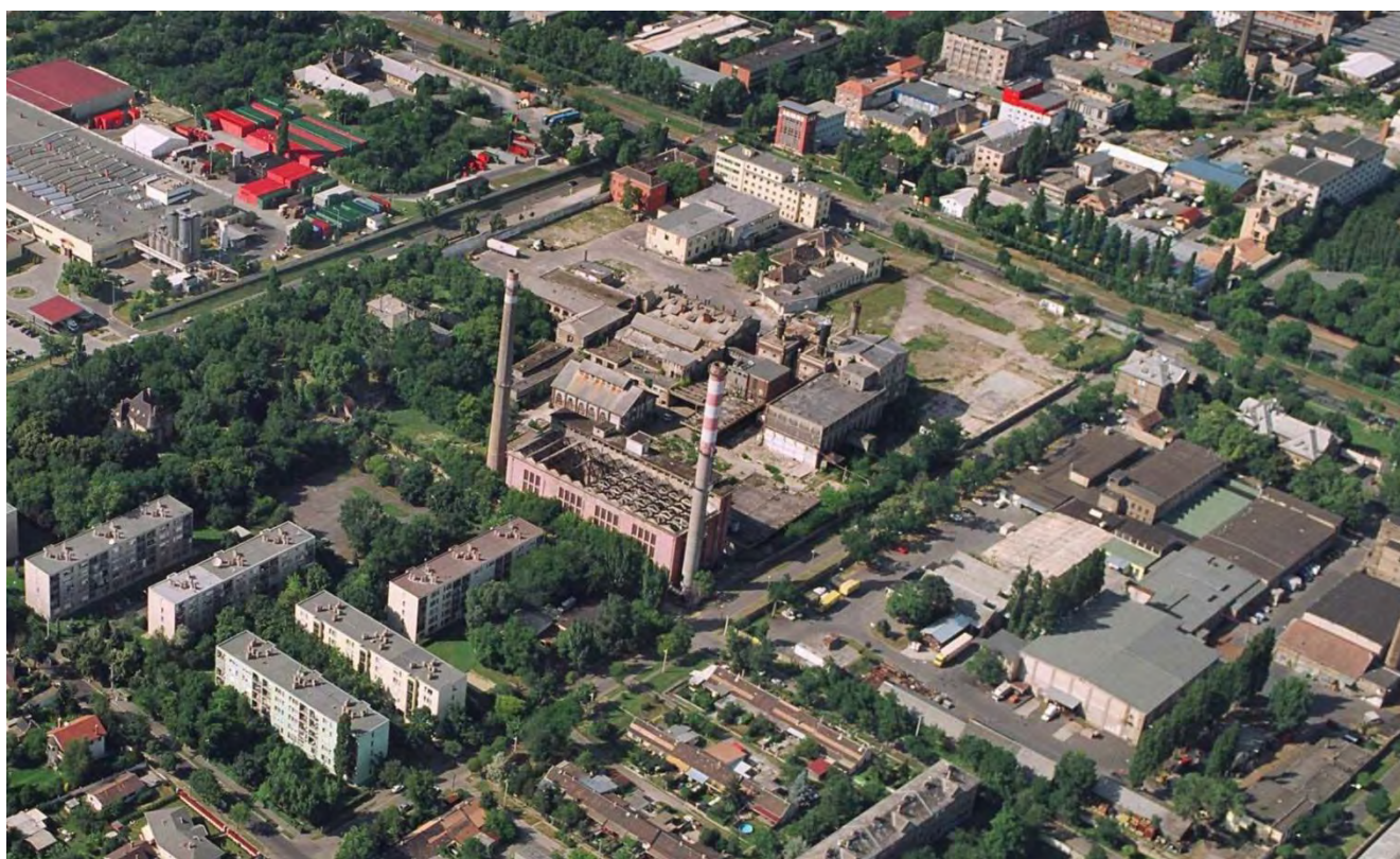
Légifotó déli irányból (a fotó készítésekor a területen még álltak az üzemi épületek és csarnokok)
