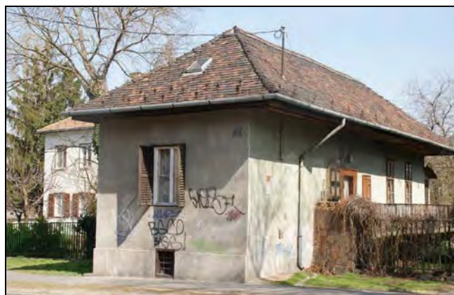
Az utcavonalból kilépő épülettömeg
