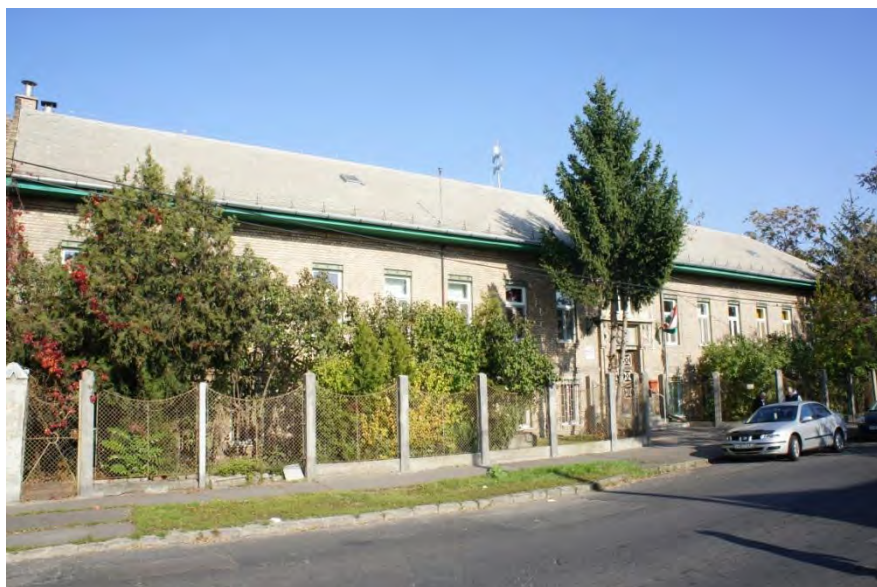
Az épület Méhes utcai főhomlokzata
