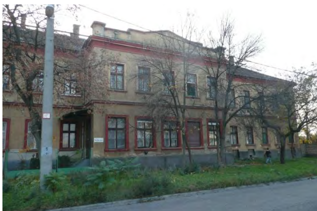
Szállás utcai homlokzat
