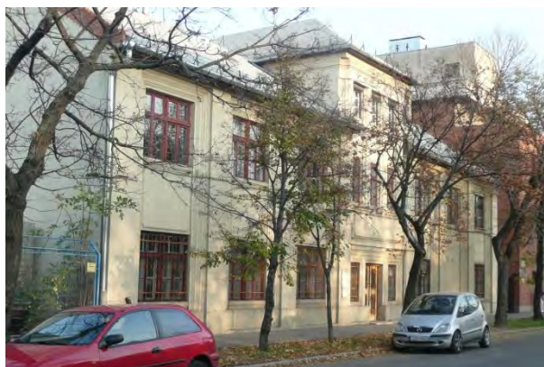
Az épület Szállás utcai főhomlokzata
