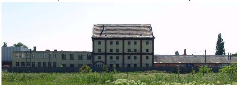
Mázsza utca épülete a Kőbányai út felől
