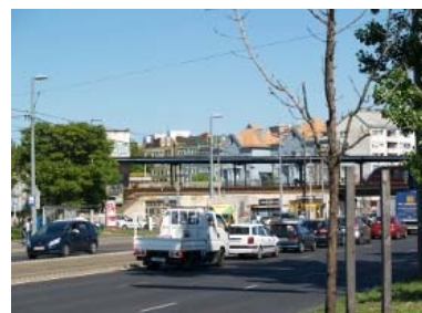
Csomópont a vasúti hídnál
