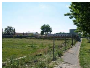
Mázsza téri építési terület
